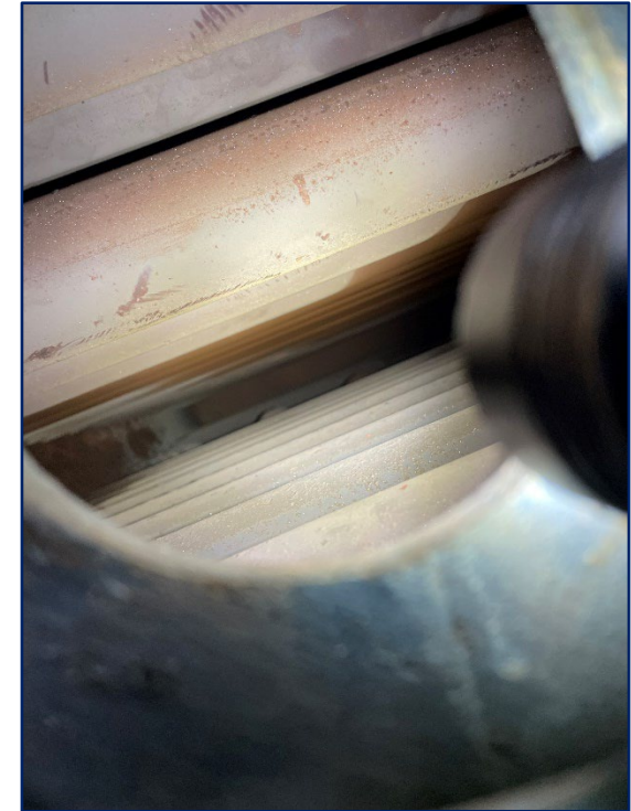
Area externa de los tubos.
